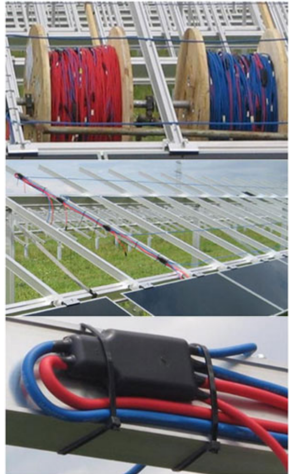
Ecostream site Baustelle-Froscham using Gehrlischer cables.
